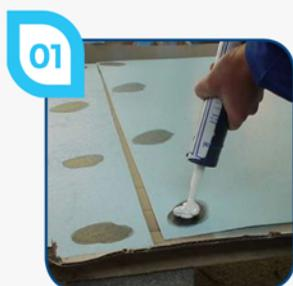
01 Appliquer la colle à l'arrière du 1<sup>er</sup> panneau puis le poser contre la surface à recouvrir
